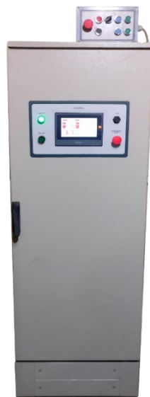
Рисунок 2.9 Шафа керування комплексом обладнання для гібридного плазмово-дугового зварювання плавким електродом.
